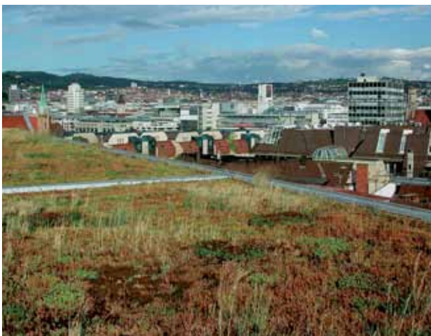
Das Förderprogramm zur Dachbegrünung umfasst die baulichen Vorbereitungen, Substratarbeiten, Aussaaten und Bepflanzungen. Copyright: Stadt Stuttgart
