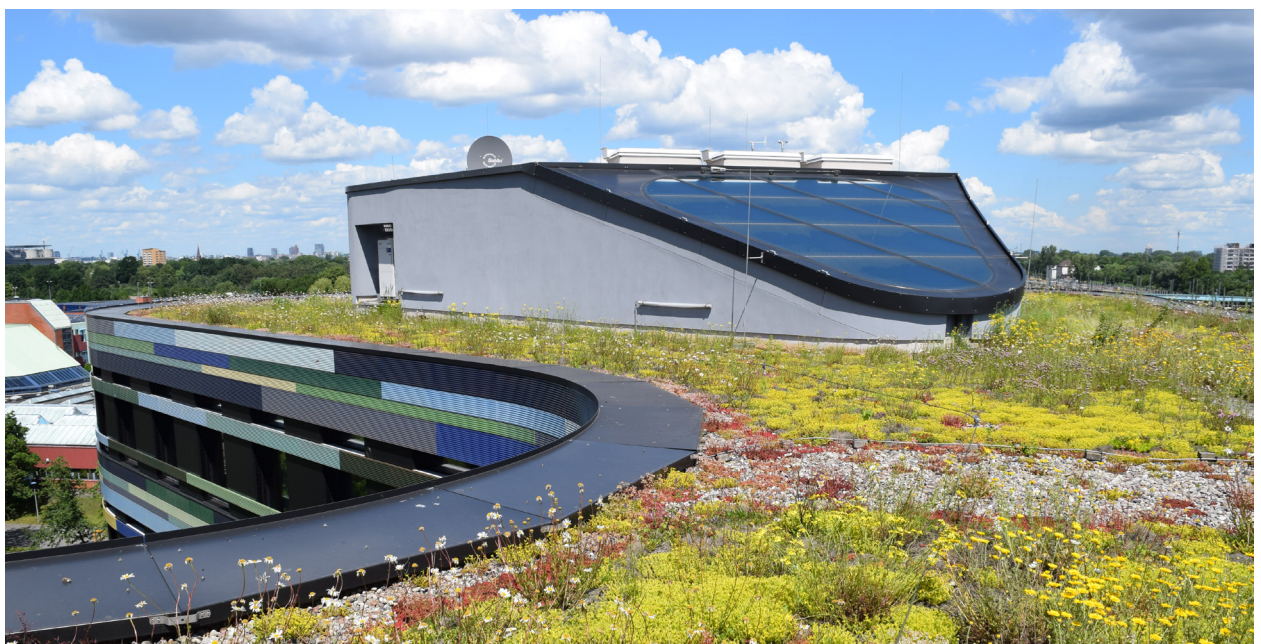
Abb. 9: Extensiv begrüntes Dach
