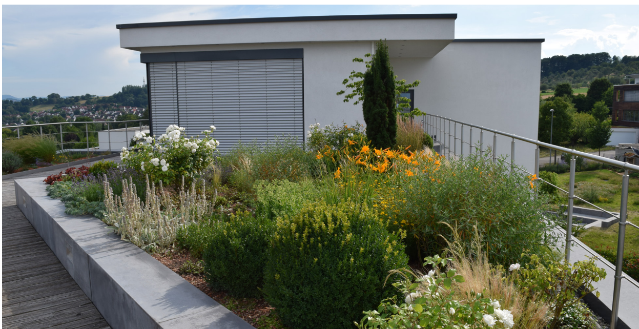
Abb. 11: Intensiv begrüntes Dach
