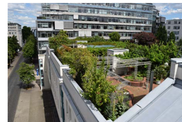
Abb. 39: Dachgarten "Feuerwache West" in Stuttgart - eine Jahrzehnte alte und immer noch funktionsfähige Dachbegrünung. Quelle: BuGG
