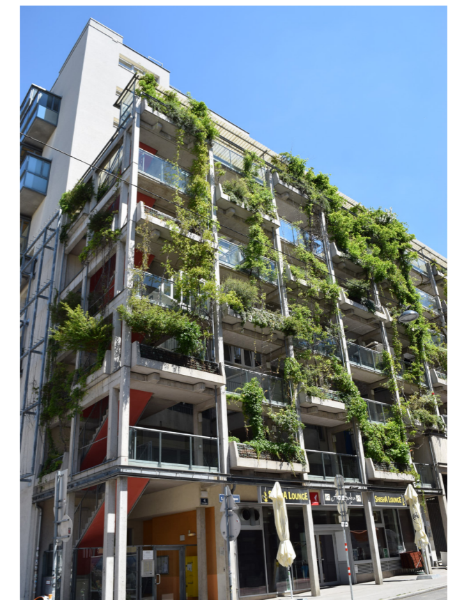
Abb. 9: Wandgebundene Fassadenbegrünung in Regalbauweise (horizontal). Quelle: BuGG
