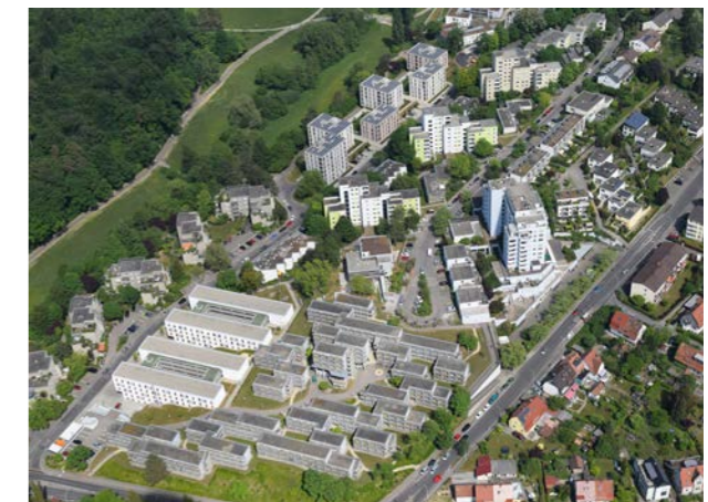
Abb. 29: Ein Blick aus der Vogelperspektive (hier Nähe Bodensee) verdeutlicht es - nur ein geringer Anteil der Dächer in Deutschland ist begrünt. Quelle: BuGG
