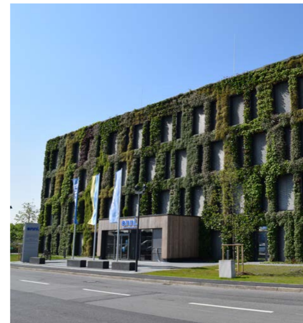
Abb. 12: Gewinner BuGG-Fassadenbegrünung des Jahres 2021: Das ENNI Verwaltungsgebäude in Moers. Quelle: BuGG
