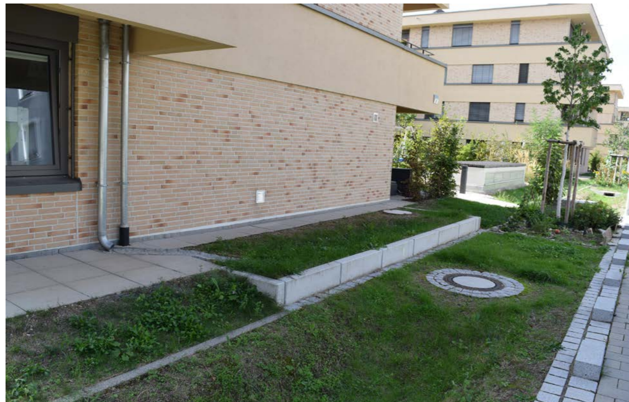
Abb. 62: Ziel der indirekten Förderung mit gesplitteter Abwassergebühr ist es, die Kanalisation zu entlasten - und ein Gründach hält zwischen 40 und 99 % des Jahresniederschlags zurück und das Überschusswasser kann z. B. einer Versickerungsmulde zugeführt werden. Quelle: BuGG
