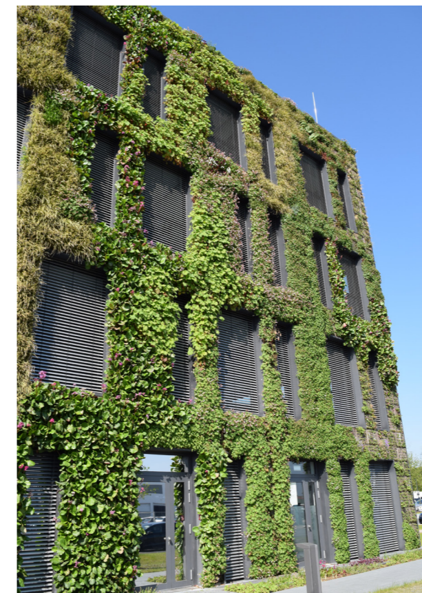
Abb. 8: „Living Wall“: Wandgebundene Fassadenbegrünung (vertikal). Quelle: BuGG
