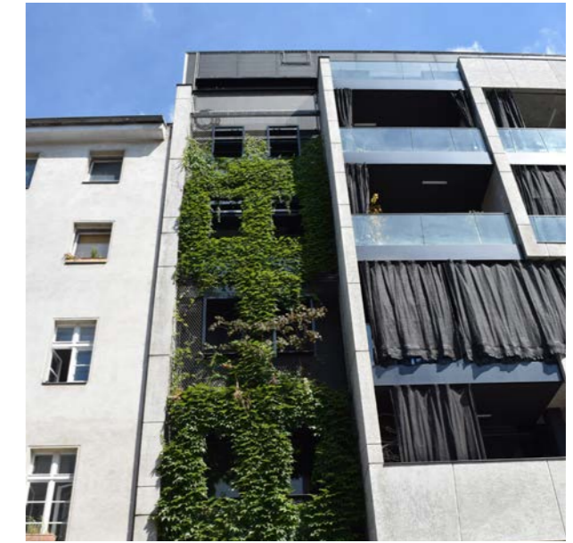
Abb. 42: Bodengebundene Fassadenbegrünungen mit Netzen bzw. Gittern lassen sich theoretisch gut erfassen ... Quelle: BuGG
