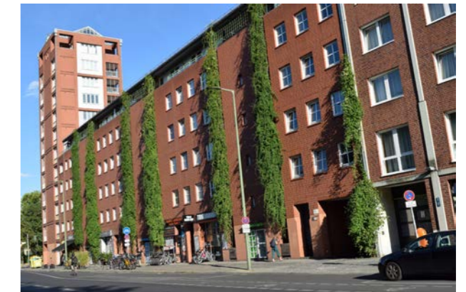
Abb. 7: Bodengebundene Fassadenbegrünung, hier mit Kletterhilfen. Quelle: BuGG
