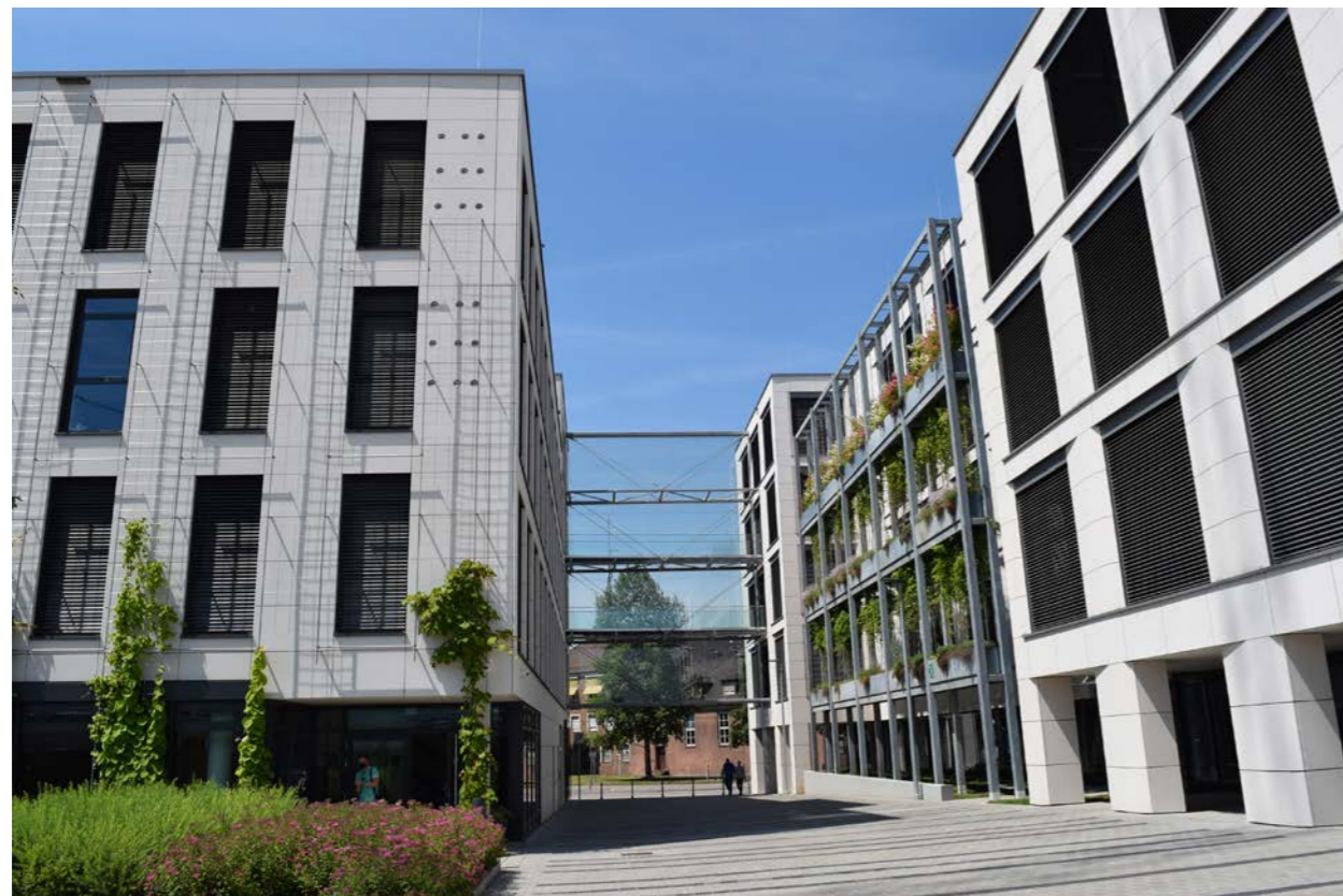
Abb. 40: In Deutschland wurden in 2021 etwa 73.000 m 2 bodengebundene Fassadenbegrünungen mit Kletterhilfen (links im Bild) und etwa 13.000 m 2 wandgebundene Fassadenbegrünungen (rechts im Bild) umgesetzt. Quelle: BuGG
