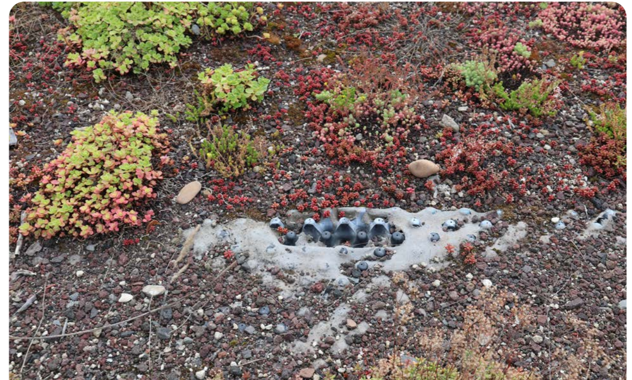
Abbildung 43: Freigelegtes Schutzvlies und der Drainage (Pflegeempfehlung: Sanierung der Dachbegrünung durch eine Fachfirma)
