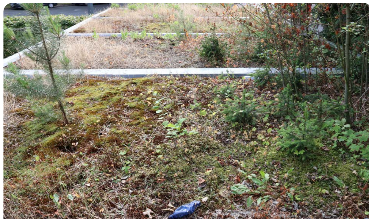
Abbildung 17: Unerwünschter Bewuchs von Kräutern und Gehölzen auf einer Sedumvegetation (Pflegeempfehlung: Entfernung der Gehölze und der unerwünschten Beikräuter mit Wurzeln)
