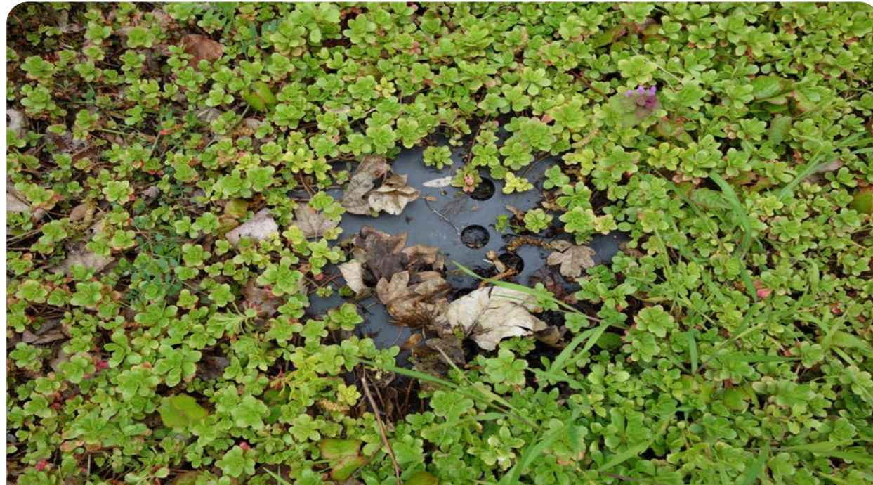
Abbildung 50: Zugewachsene Entwässerungseinrichtung (Pflegeempfehlung: Entfernung der Sedumvegetation um die Entwässerungseinrichtung herum)
