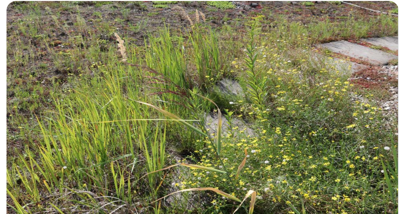
Abbildung 48: Bewachsene Plattenbeläge (Pflegeempfehlung: Entfernen der Pflanzen mit Wurzeln)
