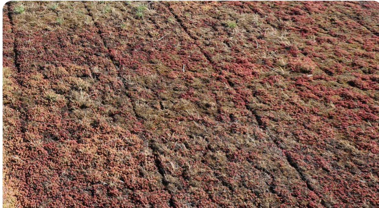
Abbildung 45: Schrumpffugen zwischen den Vegetationsmatten (Pflegeempfehlung: Auffüllen der Fugen mit Substrat)
