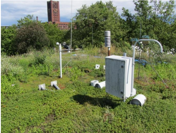
Abbildung 6 Dachbegrünung auf der UFA-Fabrik in Berlin-Tempelhof
