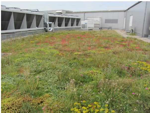
Abbildung 13 Dachflächen 2a und 2b auf dem Saturnkomplex am Alexanderplatz in Berlin-Mitte
