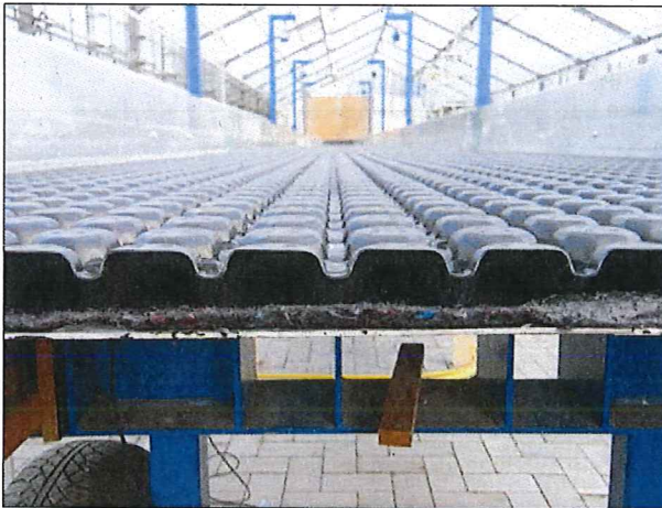
Abbildung 4: Bauweise 2, eingebaute Dränplatte auf Schutzvlies
