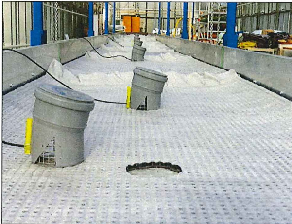
Abbildung 3: Bauweise 1 beim Einbau, Dränmatte mit Öffnungen für Kameragehäuse
