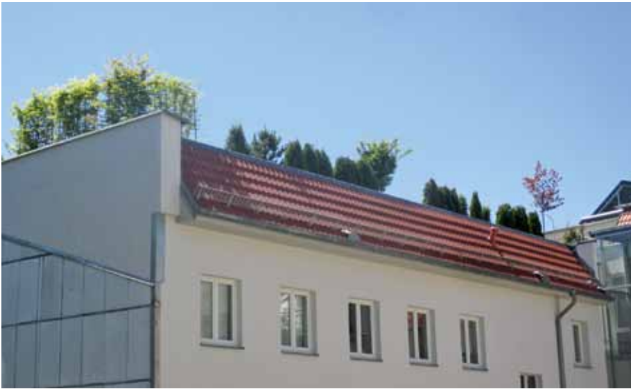
Ein Dachgarten – wie dieser in Berlin – verbessert nicht nur nachhaltig das Mesoklima von Stadtquartieren, sondern bietet auch den Bewohnern eine Entspannungszone. Bild: Frank Hartmann
