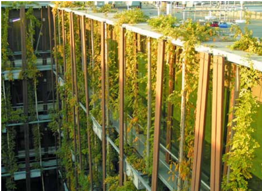
Fassadengestaltung mit begrüntem Laubgang.
