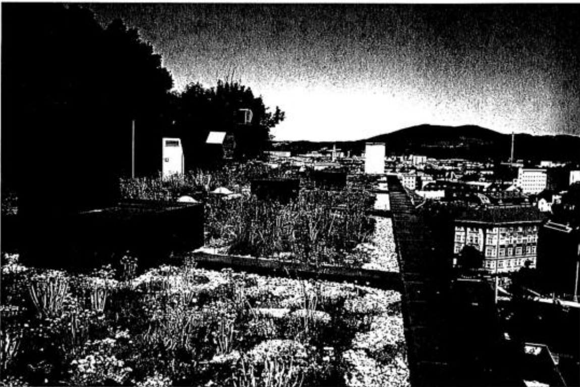
Abb. 6: Beispiel einer Sedum-Gras-Kraut-Begrünung (Objekt MK )
