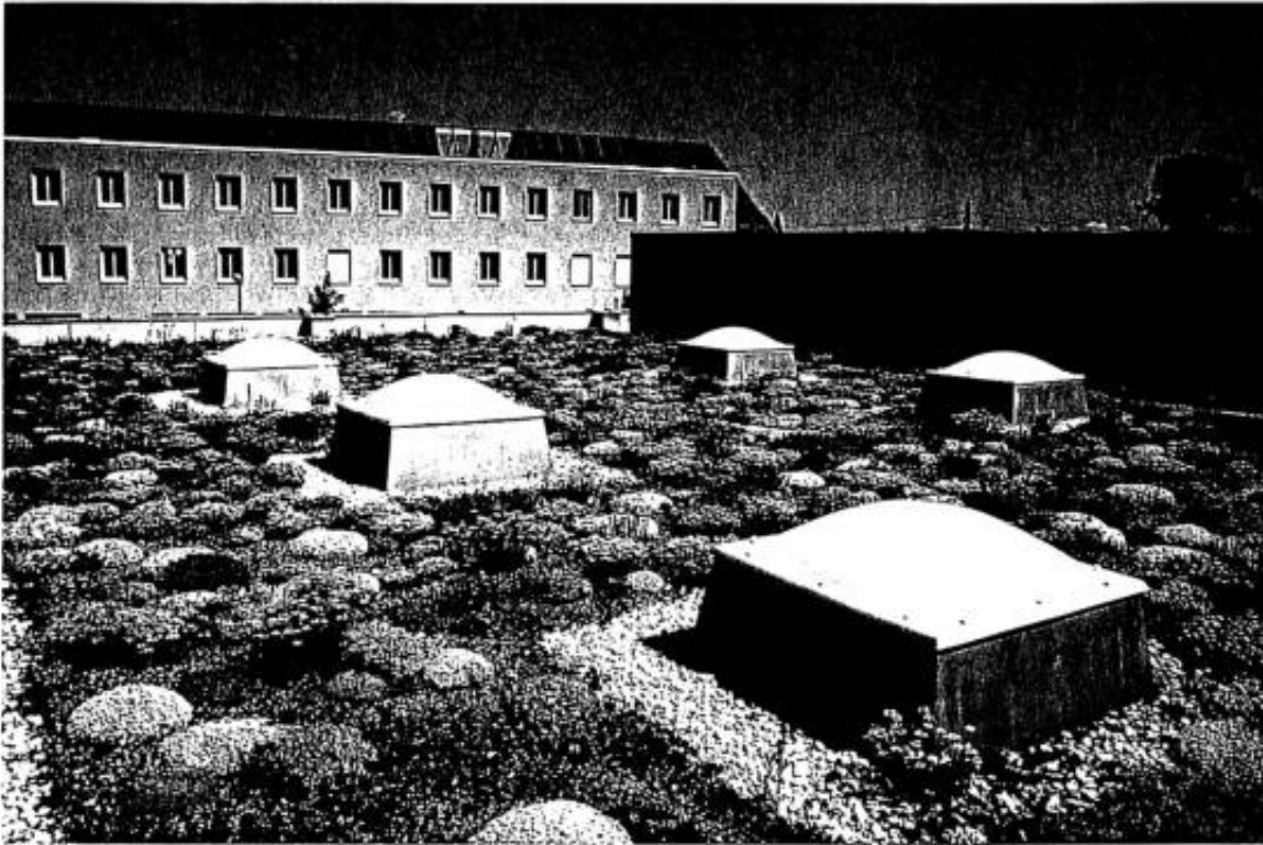
Abb. 5: Beispiel einer Moos-Sedum-Begrünung (Objekt Ba )
