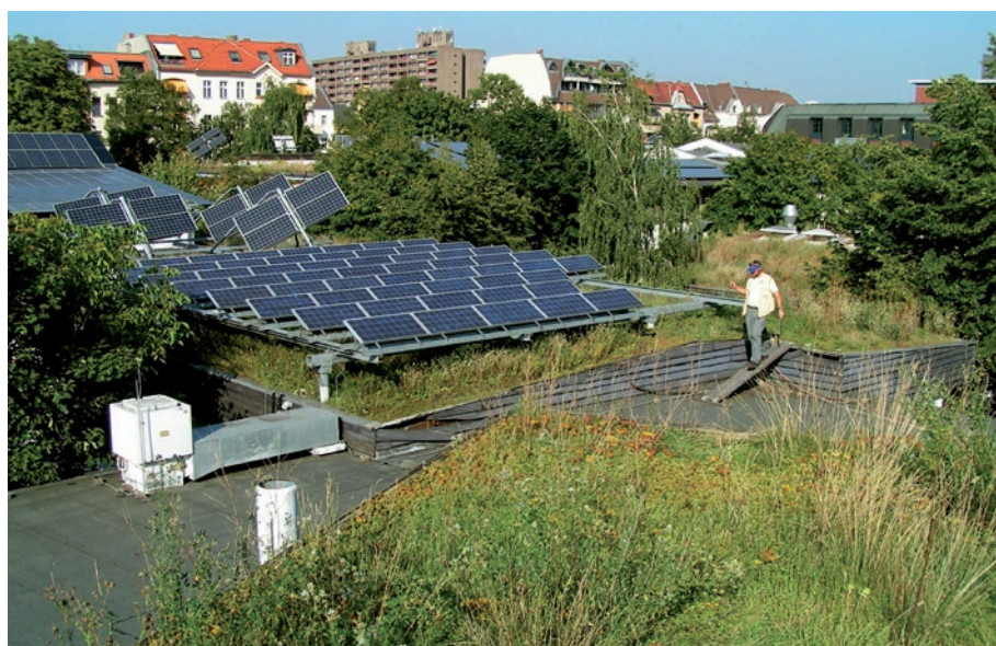
PV-Anlage auf extensivem Gründach als gelungene Synergie
