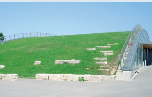
Dachbegrünung als „Freiflächenpotential“
