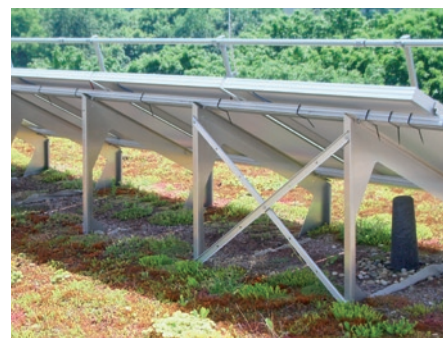
PV-Anlage auf extensivem Gründach als gelungene Synergie
