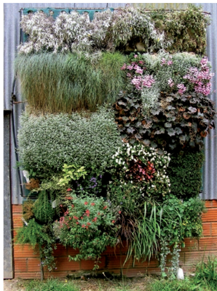
Gut entwickelte Fassadenbegrünung in Kübeln, das Projekt Physikgebäude Berlin-Adlershof im Jahr 2006
