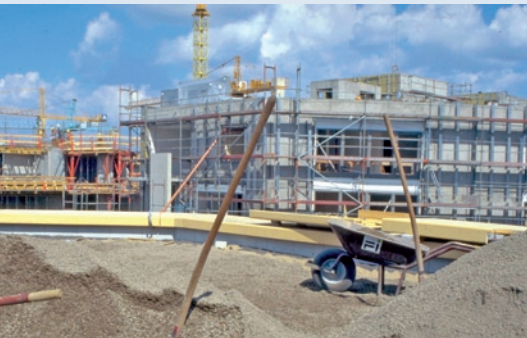
Potsdamer Platz – Aufbringen des Substrates
