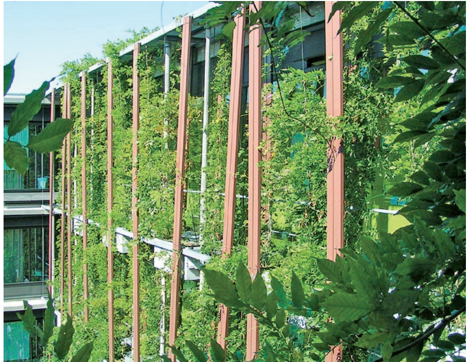
Gut entwickelte Fassadenbegrünung in Kübeln, das Projekt Physikgebäude Berlin-Adlershof im Jahr 2006
