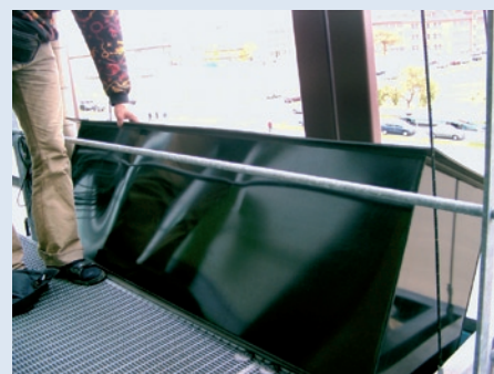
Das Beispiel Kübelisolierung am Physikgebäude in Adlershof: außen: Faserzement-Beton; mehrere Zentimeter Isolierung sowie ein Kunststoff-Innenkübel für die Bepflanzung.
