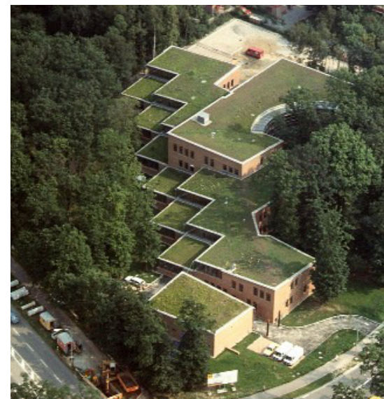
Abbildung links: Objektbeispiel aus dem Jahr 1987 (jetzt 30 Jahre) PVC-Abdichtung, 2,4 mm, E: GV, Pultdachflächen, extensiv begrünt.
