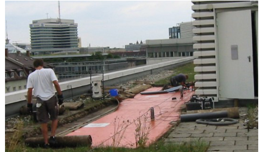
Abschnittsweise Komplettüberarbeitung der Abdichtung durch Umlagerung der Begrünung auf der Dachfläche. Auf ca. 800 m 2 wurden über 100 Mangelstellen gefunden.
