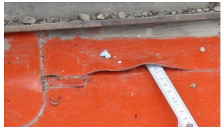
Abschnittsweise Komplettüberarbeitung der Abdichtung durch Umlagerung der Begrünung auf der Dachfläche. Auf ca. 800 m 2 wurden über 100 Mangelstellen gefunden.
